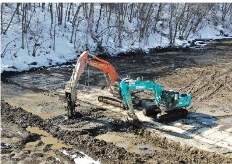
地盤改良状況
